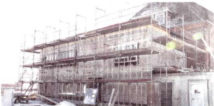
Der Erweiterungsbau Anfang Februar.
